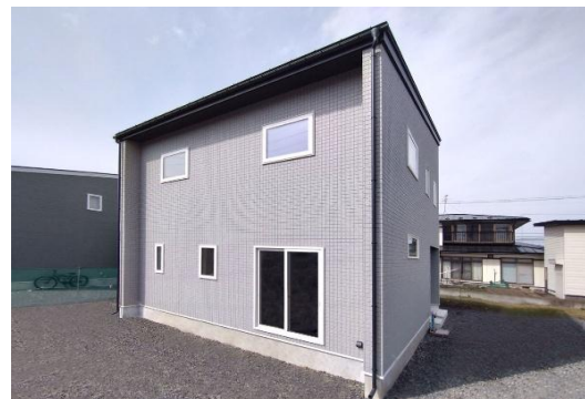
オール電化住宅
